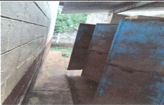
Foto 3: Mantenimiento a estructura (lijado, cambio de tubo, cepillado, sujeciones, aplicación de pintura) a puertas servicios sanitarios
