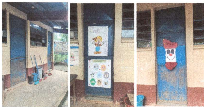
Foto 7: Mantenimiento a estructura (lijado, cambio de tubo, cepillado, sujeciones, aplicación de pintura) a puertas servicios sanitarios
