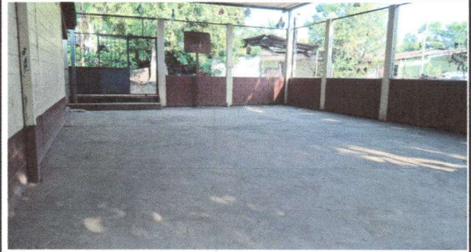
Foto 2: Reparación de piso de torta de concreto
