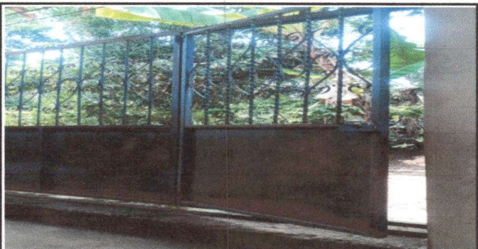
Foto 6: Mantenimiento a portones de metal.
