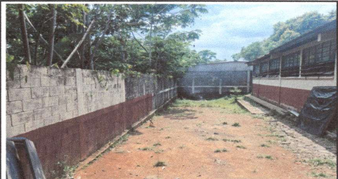
Foto 4: Pintura en muros exteriores e interiores
